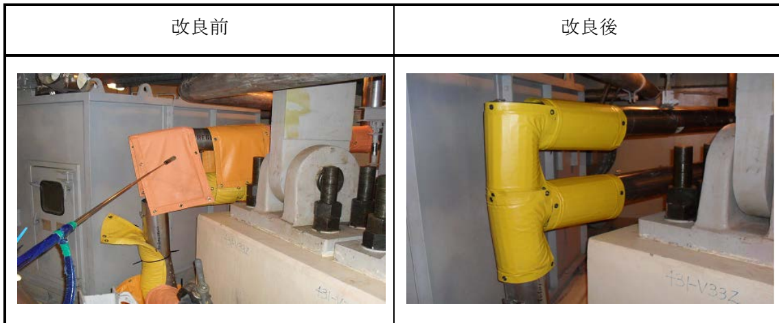
写真 4 : RCB 86'の内壁に設置されているキャビティファンの廻りの配管を遮蔽
