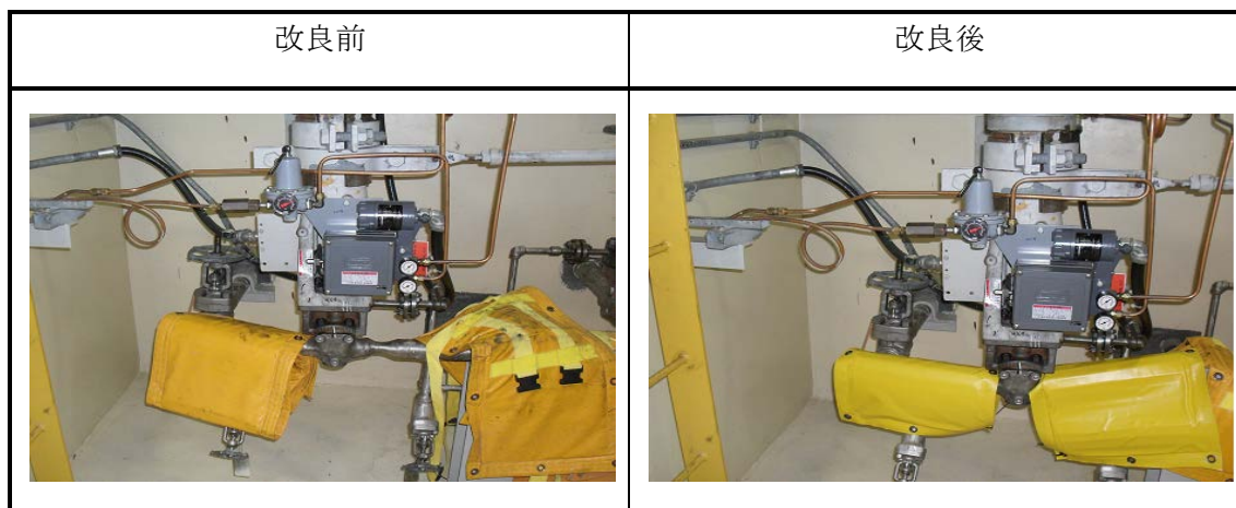
写真 7 : SAB 10'レットダウン内の 441-201Q の高線量配管
