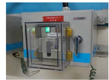
조작 스위치에 보호커버 설치
