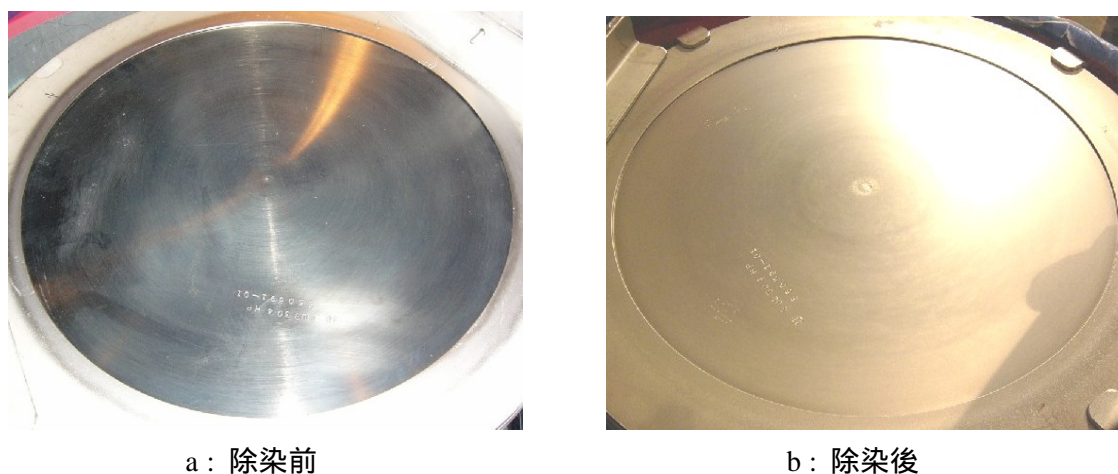
Fig.3 実機適用試験状況
