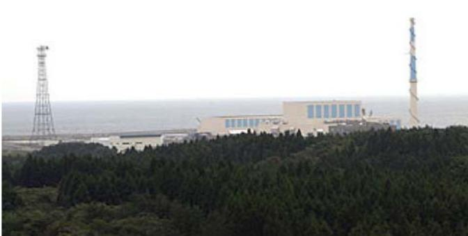
東通原子力発電所は、青森県下北半島の東側、太平洋に面した東通村に立地する。1号機は出力 1100 MW の沸騰水型軽水炉である。この原子力発電所は、主に原子炉建屋、タービン建屋、サービス建屋、及び海水熱交換器建屋からなる。東通 NPS は 1998 年 12 月に起工し、商業運転は 2005 年 12 月に始まった。
