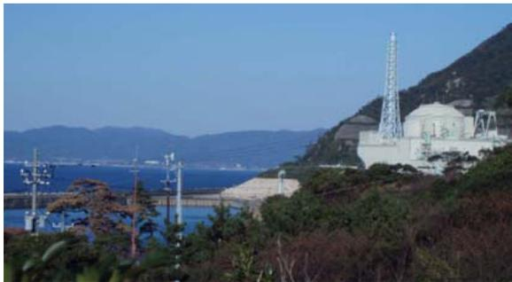
「もんじゅ」FBR 原型炉は、280 MW の電気出力である。最初の臨界を 1994 年 4 月に達成した。1995 年 8 月、「もんじゅ」は日本で最初の発電用の FBR となった。現在でも、高速増殖炉を使用して発電できる日本で唯一の施設となっている。1995 年 12 月、二次系配管の温度センサーからナトリウム冷却材が漏洩した。以後、プラント運転は停止している。
